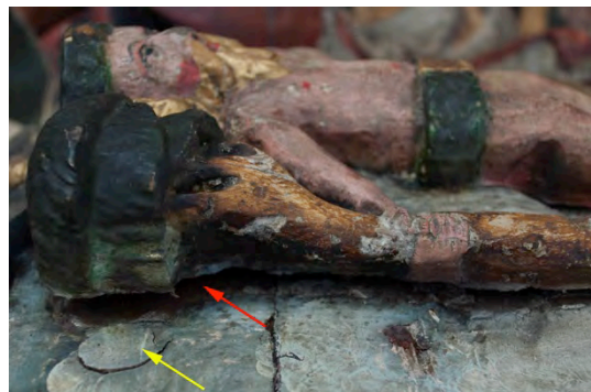
Fig. 75 Detaljebilde av villmann i våpenskjoldet. Gul pil: en kvist som har arbeidet seg utover; rød pil: sprekk i sammenføring mellom villmann og rammeverket
