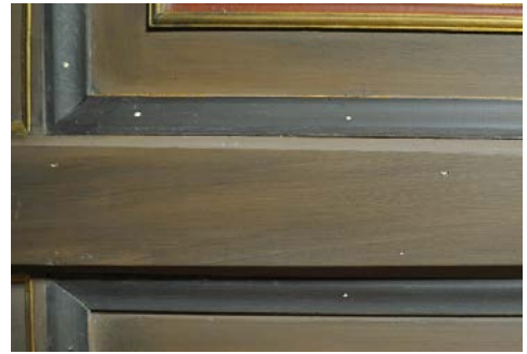
Fig. 13. detalj av nordre sekundære felt. Hvite prikker er sparklede spikerhoder.
