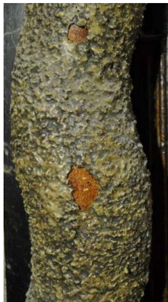
Fig. 14. Avskallinger ned til lakk-lag på venstre søyleskaft. Den gulige fargen skyldes overskudd av voks.
