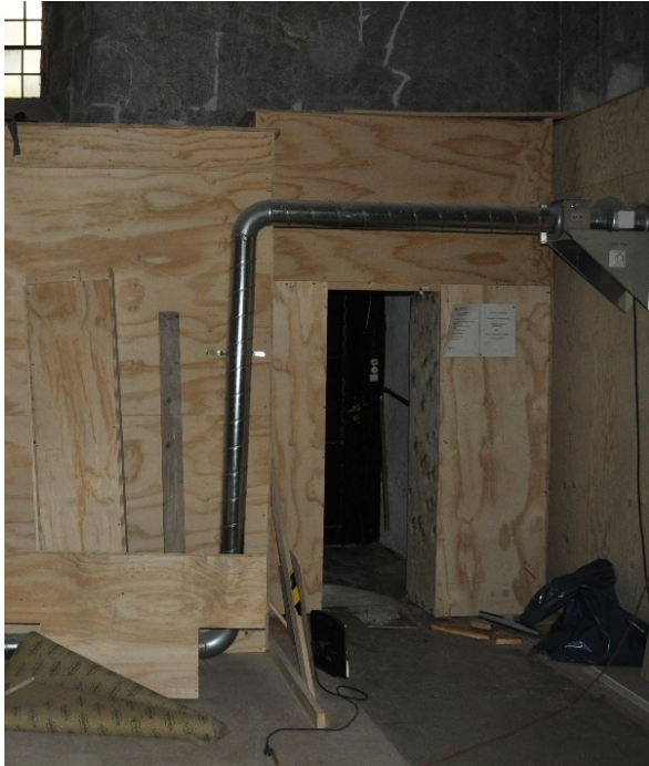
Fig. 2. Innkassingen av sakristidørens omramming under byggeprosessen.
