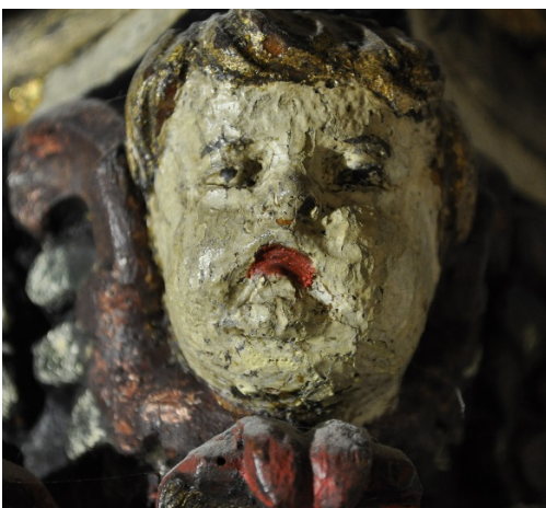
Fig. 6. Englehode på venstre søyles kapitel med tidligere sjuskete utbedringer.
