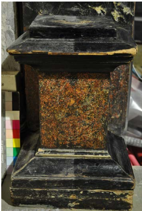
Fig. 24. Vestre søylesokkel under rensing av fastsittende smuss.
