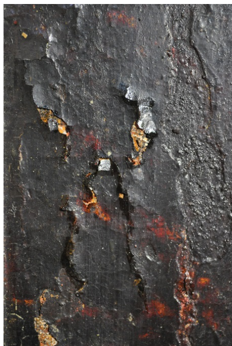
Fig. 22. Opp- og avskallinger på felt med skilpaddeimitasjon bak høyre søyle før konsolidering. En tidligere utbedret skade sees til høyre.
