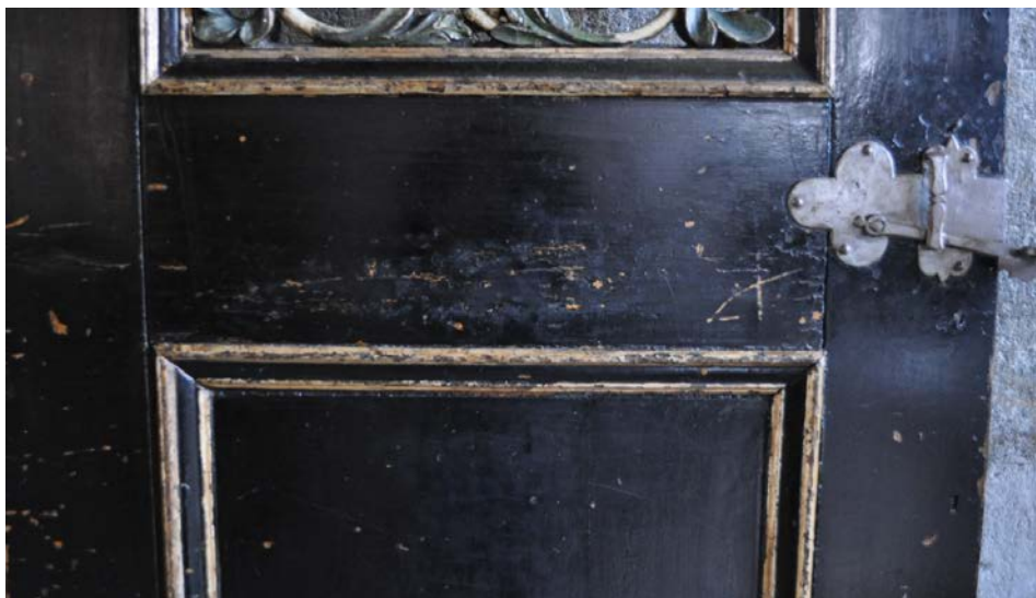
Fig. 12. Slitasje og mekanisk påførte skader på dørbladets sakristiside.
