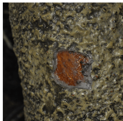
Fig. 26. Vokskitt er påført langs skadekantene
