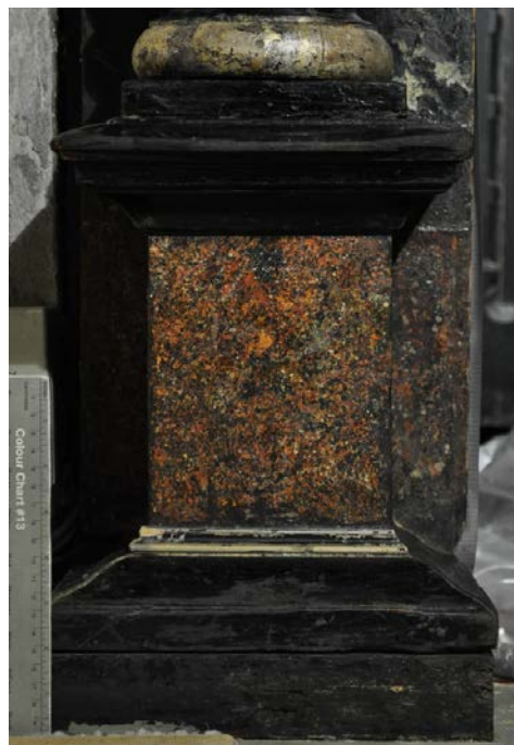
Fig. 25. Venstre søylesokkel etter rensing og nesten ferdig retusjert.
