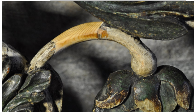
Fig.18. Innfelling av nytt treverk på manglende del av stengel. Sett fra dørbladets sakristiside.
