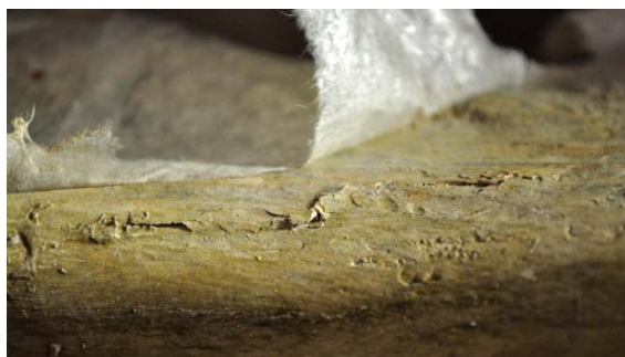
Figur 7 Detaljfoto av oppskallinger før konsolidering
