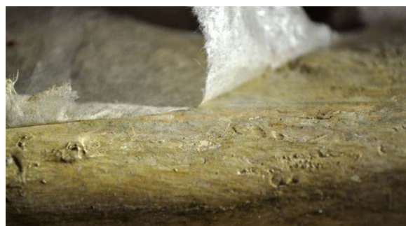
Figur 8 Detaljfoto av oppskallinger etter konsolidering
