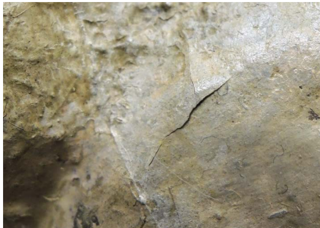
Figur 5 Detaljfoto av oppskalling
