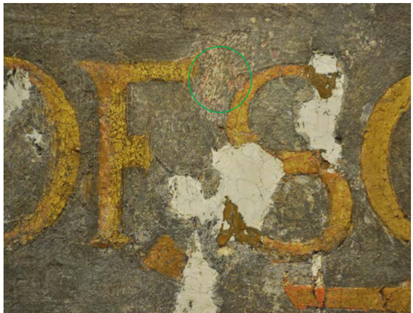
Fig.15. Samme detalj som fig.11 etter fjerning av overmaling. Grønn sirkel markerer område med kvist hvor mønjefarget kitt (trolig benyttet for å fylle ujevnheter) sees som små røde punkter. Skiller seg ut fra de øvrige kittingene for skader.
