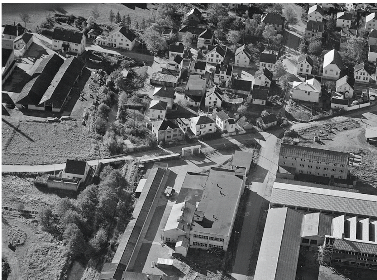
Figur 26: Den åpne Storåna-elven ved Gjestalveien i 1955.
