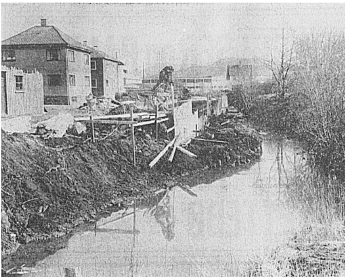
Figur 28: Anleggelse av kulverten gjennom Fjerå i 1975.
