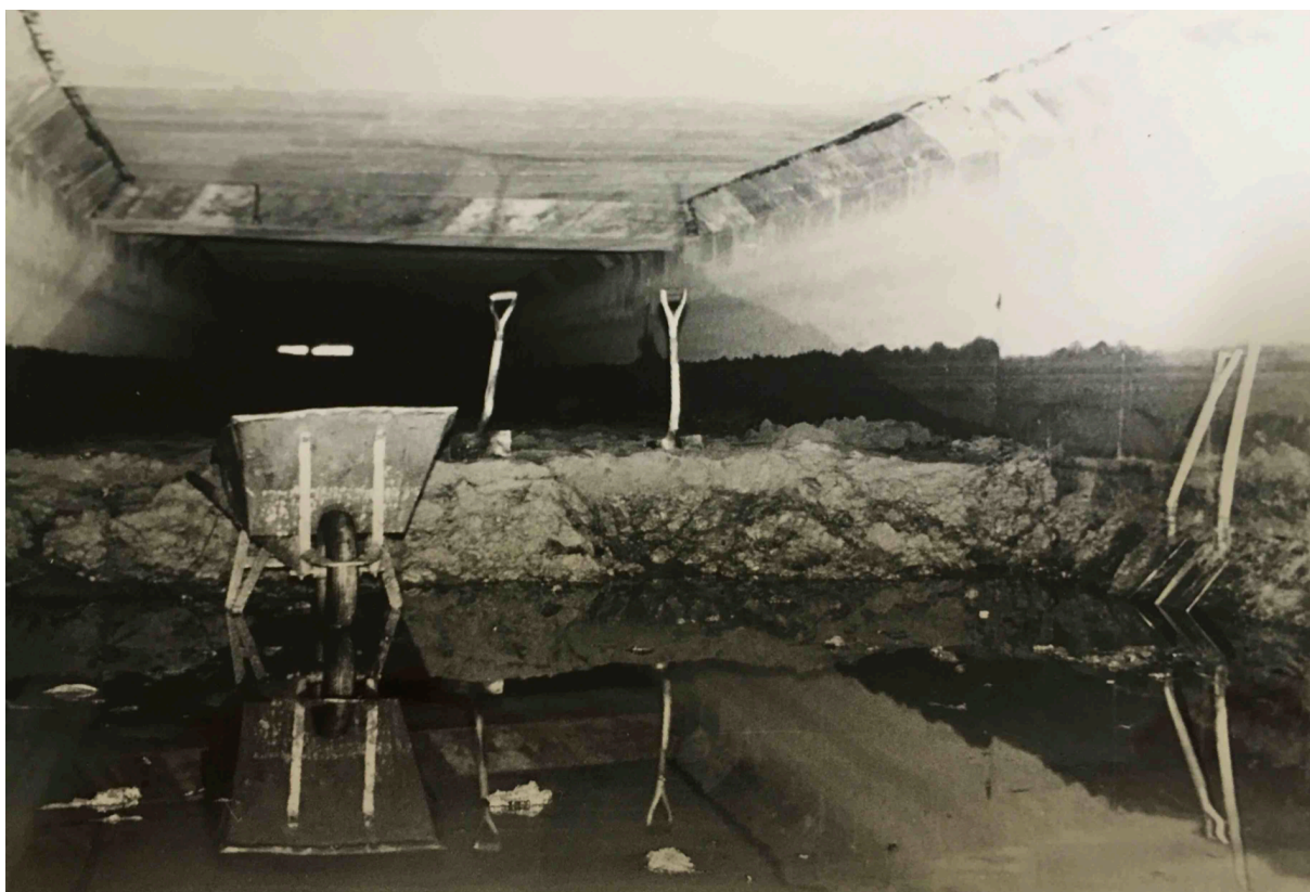
Figur 29: Utgravning av sedimenter fra kulvertene.
