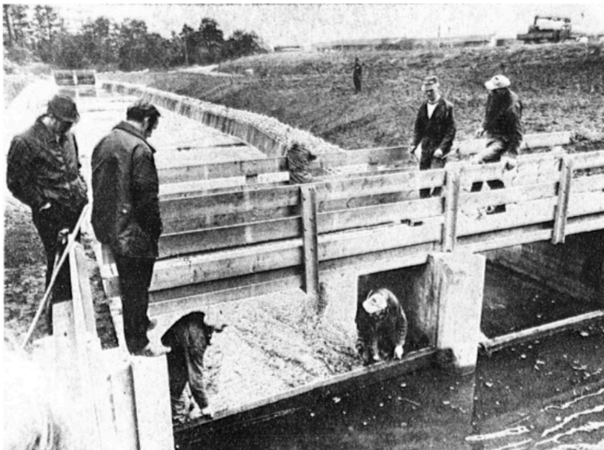
Figur 31: Sandfangbassenget åpnes i 1972.
