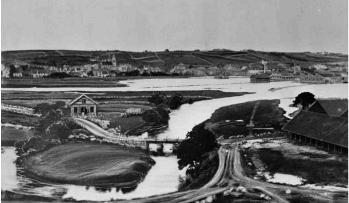
Figur 15: Fjerå før den ble tørrlagt ut på 1900-tallet.
