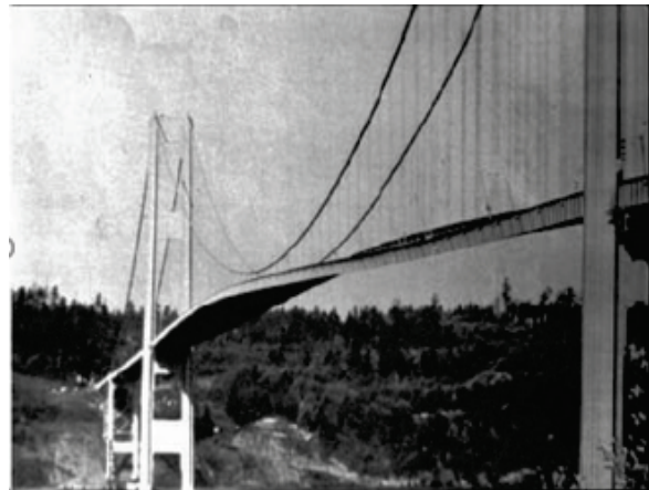
Figur 1.3 Tacoma Narrows Bridge etter kollaps [7, s. 17]
