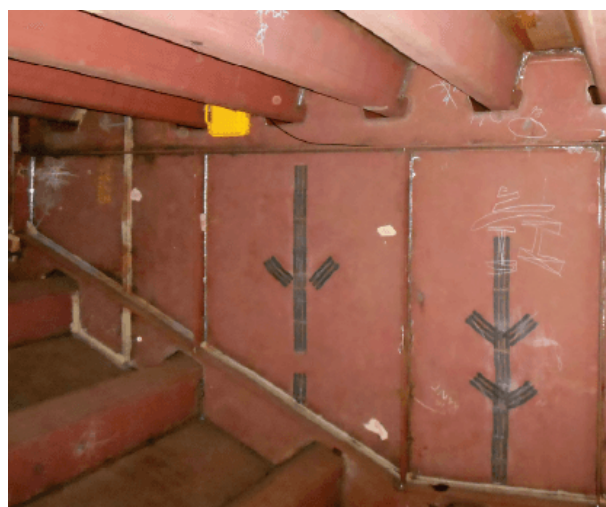
Figur 3.14 Plassering av akselerometer i brokasse [31, s. 6]
