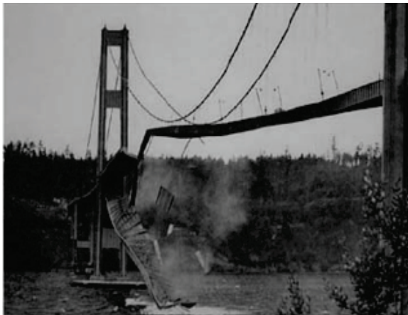
Figur 1.2 Tacoma Narrows Bridge før kollaps [7, s. 17]
