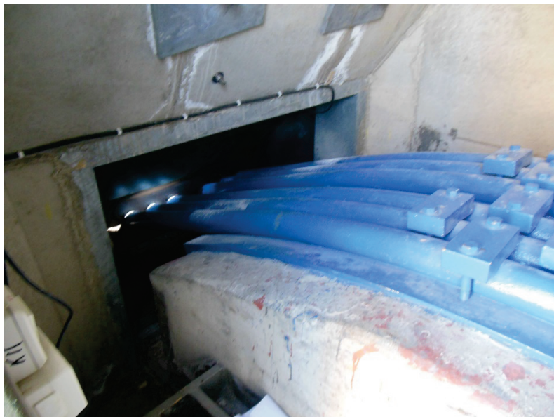
Figur 3.6 Tårnsadel i det sørlige tårnbenet, Foto: Jonas Snæbjørnsson
