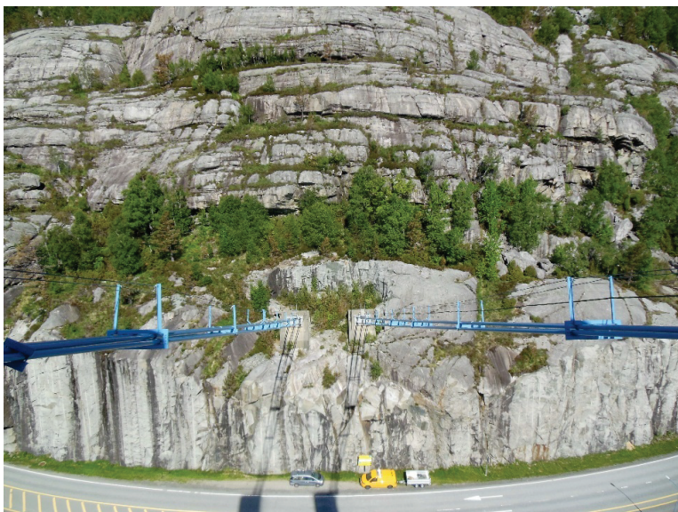
Figur 3.8 Fundamentering i fjell, nordvestlig side, Foto: Jonas Snæbjørnsson
