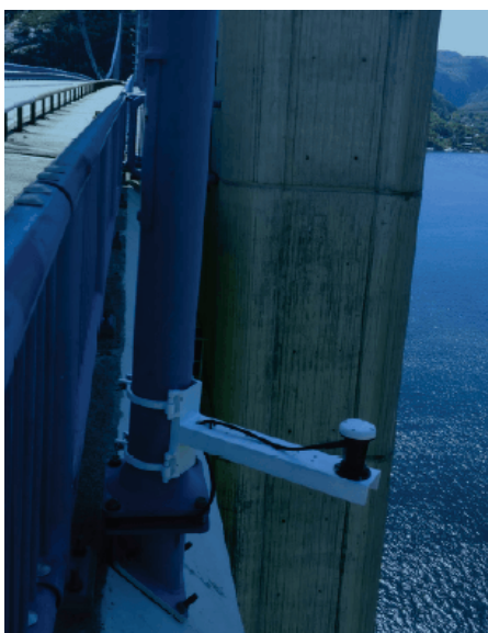
Figur 3.17 RTK-GPS, base-antenne [31, s. 6]
