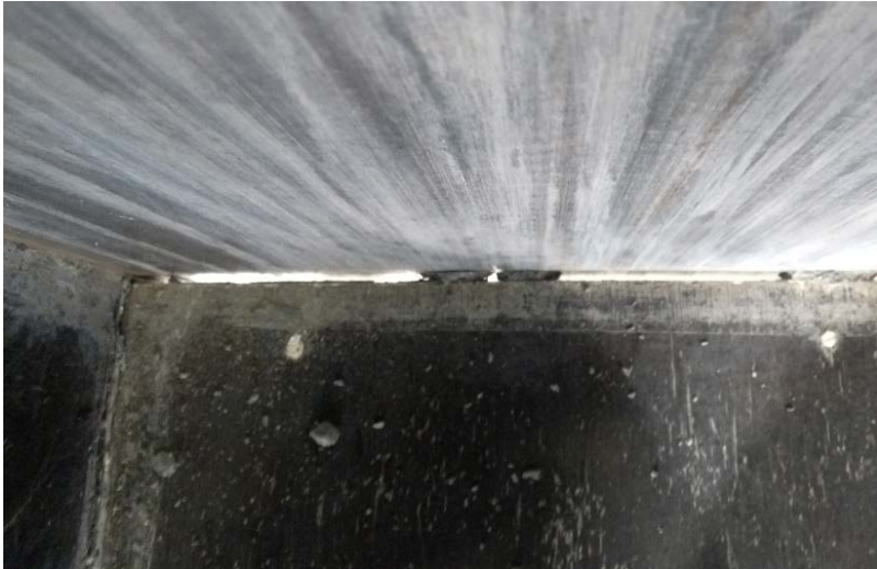
Figur 29 stein/ grus fastkilt mellom form og glidepanel
