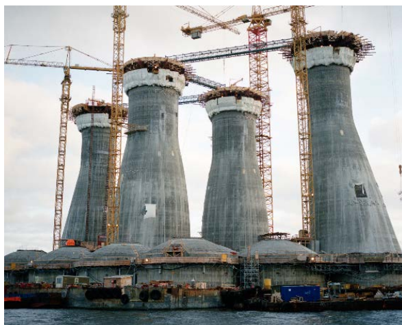
Figur 16 eksempel på konisk utført glidestøp [1]
