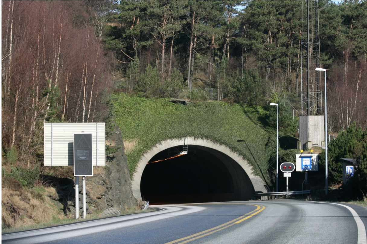
Figur 4: Inngangsportal til Byfjordtunnelen på Sokn. (Photo: Jarle Vines (Creative Commons Attribution Sharealike 3.0))
