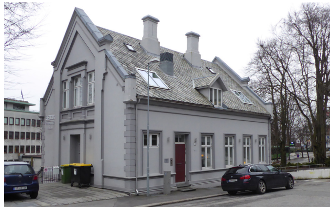
Figur 4.28: Murbygg i Knud Holms gate 1, fra 1881.
