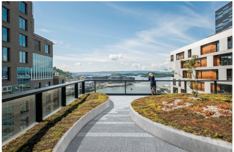
Figur 4.6: Fordøyende uterom på tak. (Multiblokk, s.a.a) Figuren viser hvordan man kan kombinere ulike bruksområder og overvannstiltak på tak.
