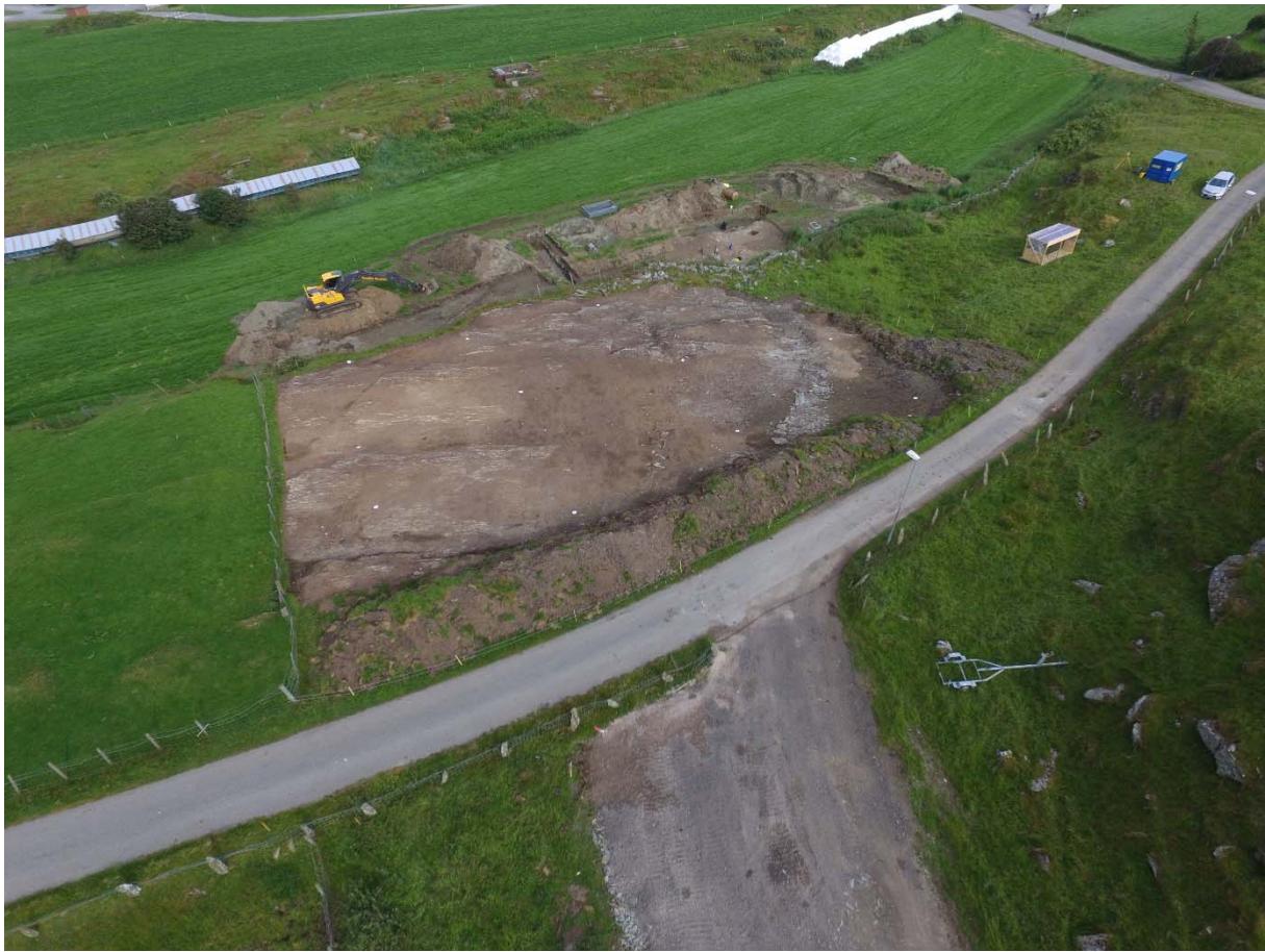
Figur 128: Lok 3 etter avdekking. Det forhistoriske sundet går langs stripen av dyrket mark hvor gravemaskinen står. Bildet er tatt mot vest.
