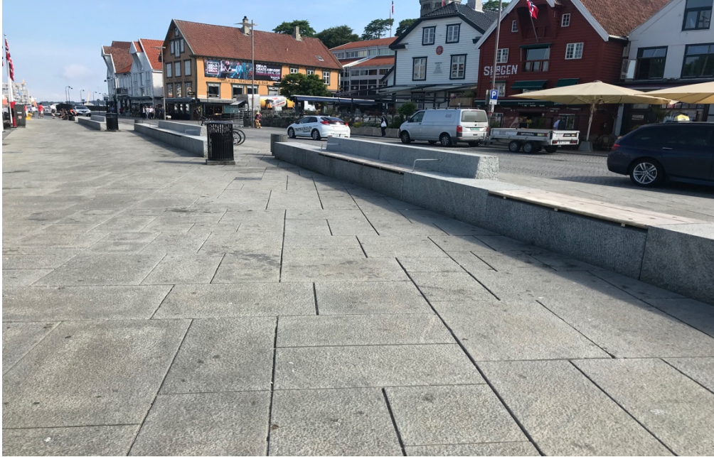
Bilde 6. Flomsikring i Stavanger. Foto: Irja C. Hagerup
