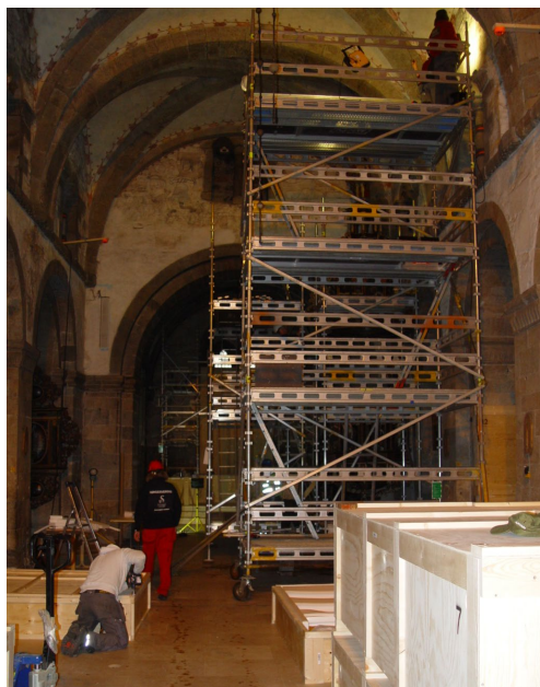
Arbeidet med prekestolhimlingen ble utført fra to sidestilte stillas. Konservatorer fra NIKU arbeidet parallelt med tilstandsvurdering av kalkmalerier.
