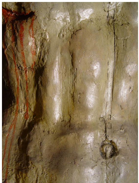
Foto 2. Detalj av overflate med nivåforskjeller etter flere oppkittinger av skader. Før forsidesikring.
