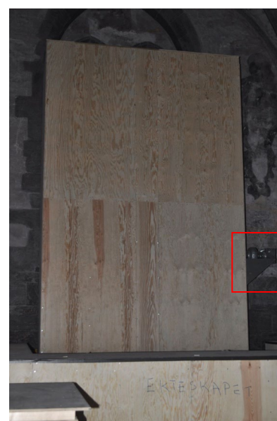
Alterskapet innkasset. Utvendig vifte merket med rødt.
