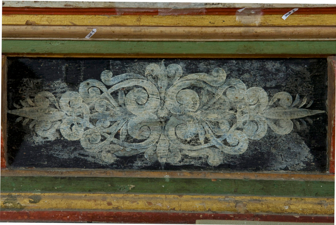
Fig. 21: Voksoverskudd som har blanchet i midtre felt på sokkelen.
