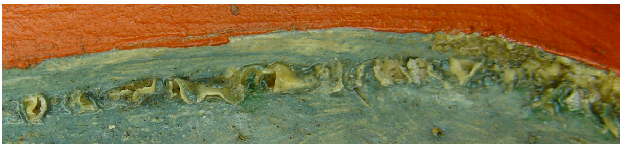
Fig. 16: Detaljfoto av "krøllete" oppskallinger ( Venstre vinge)
