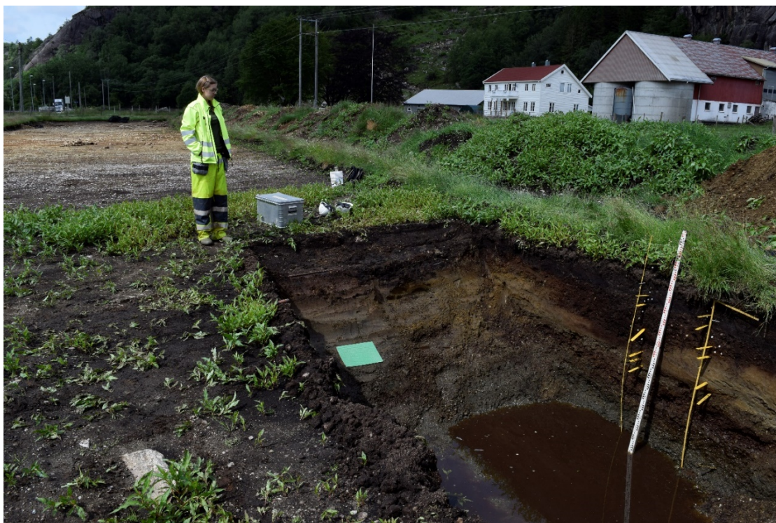
Figur 32: Foto av utgravd sjakt sett mot vest og i forlengelsen av Felt 1. Sett mot V
