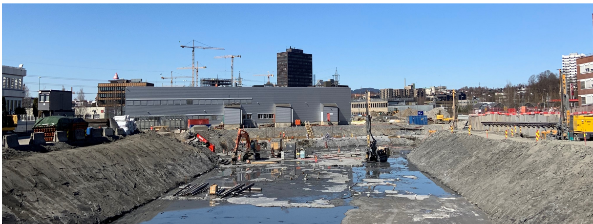
Figur 6.5: Byggegroppen på Ulven B2
