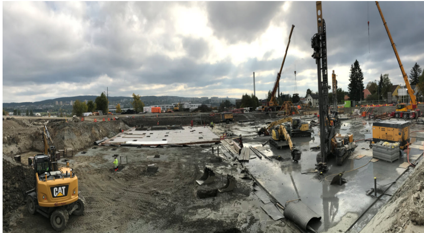
Figur 4.5: Grunnarbeidene ved Vollebekk
