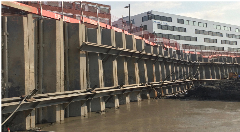
Figur 5.16: Spuntvegg av U-spunt med dyblinger og dobbel puterad med lissestag
