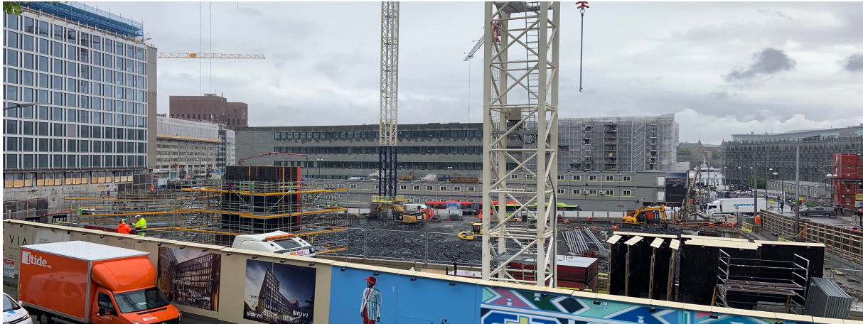
Figur 6.4: Byggegroppen på VD prosjektet "R24", som ligger i Vika i Oslo
