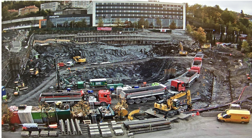
Figur 5.7: Effektiv og trygg organisering av utlasting
