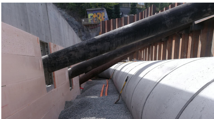
Figur 6.9: Stempingen av Spunveggen gikk gjennom kjellerveggene
