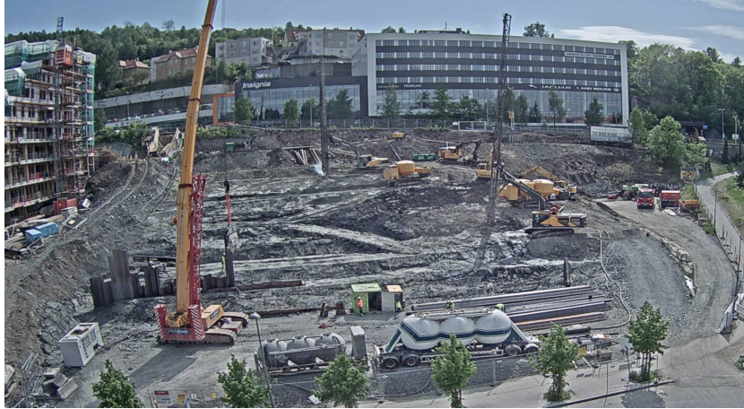
Figur 6.11: Foto hentet fra webkameraet til byggeplassen
