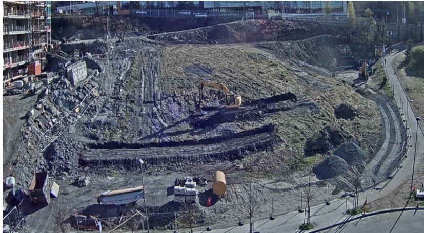
Figur 4.7: Oversiktsbilde av tomten, tatt rett etter oppstarten
