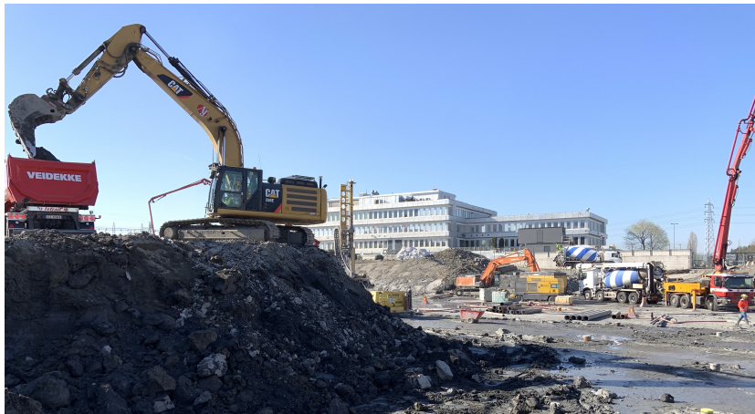
Figur 5.6: Graver brukt til utlasting
