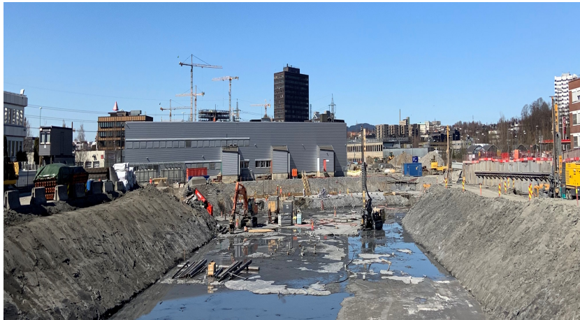
Figur 4.2: Byggegroppen på Ulven B2
