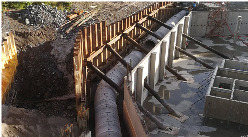
Figur 6.8: Rørgate gjennom tomten
