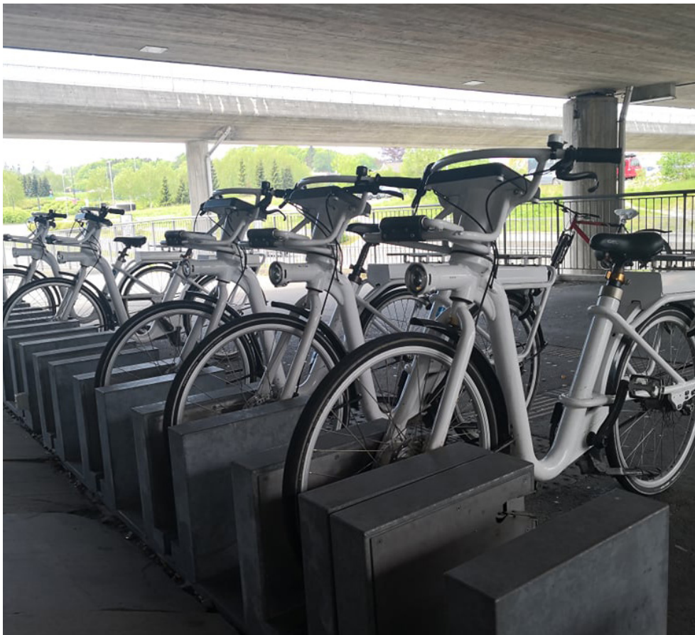
Figur 59 : Bysykelstasjon som er lokalisert under Jernbanebru
