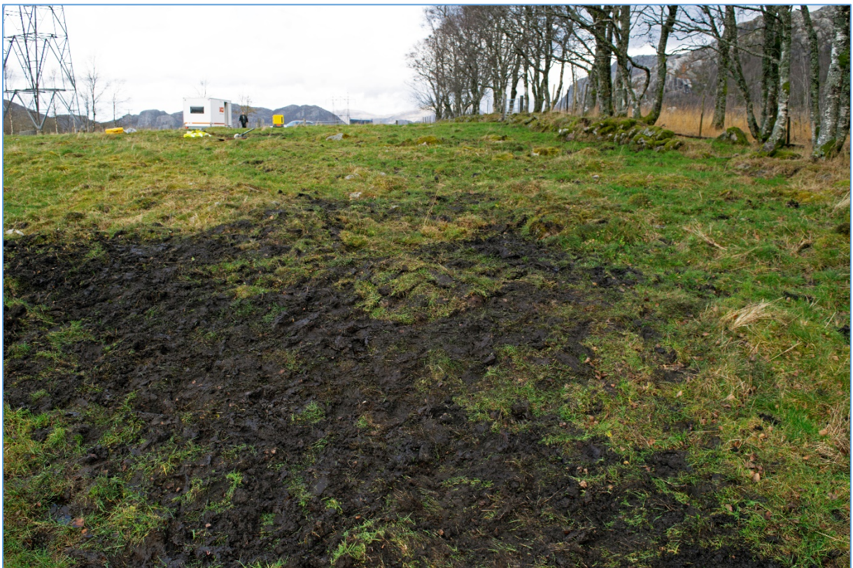
Figur 15 Sjakt 1, situasjon etter ferdig attfylling med torv. Foto mot NNØ.
