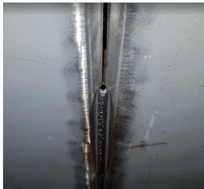
(d) Root pass of single-V groove weld, frontside PL3.
