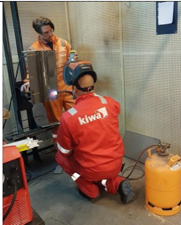
(d) Preheating with propane to 50 °C.
