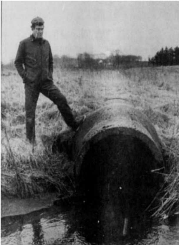
Figur 25: Formann i bekkelaget Lars Ødemotland og den problematiske overvannsledningen.
