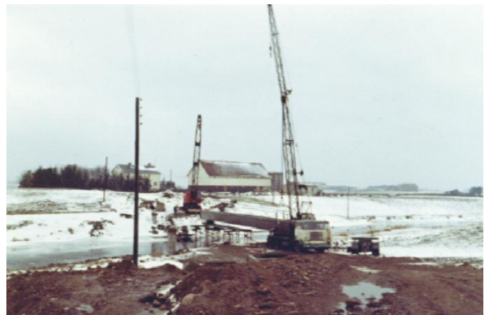
Figur 23: Nordsjøen skulle altså erstatte Dalabekken som resipient. Her legges kloakkledningen fra Nesheim til Nordsjøen.
