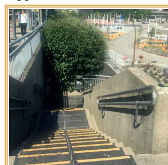
Figur 3-27 // Trapp ned fra platformen, rekkverk i to høyder langs begge sidene nedover.
