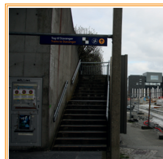
Figur 3-29 // Trappe opp til plattformen. Trappen tar også en 90 graders sving.
