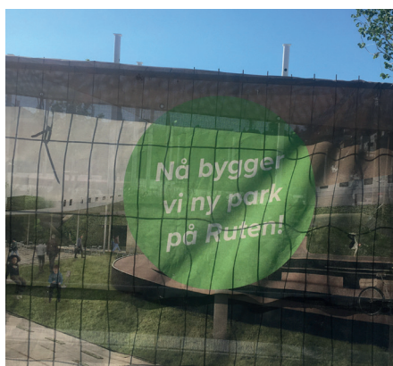
Figur 3-43 // "Her bygger vi ny park på Ruten" skilt. Pågående prosjekt som skal stå ferdig snart.
