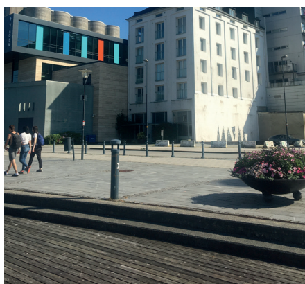
Figur 3-71 // Her må man ned to trinn for å komme på brygga, ingen rampe.
