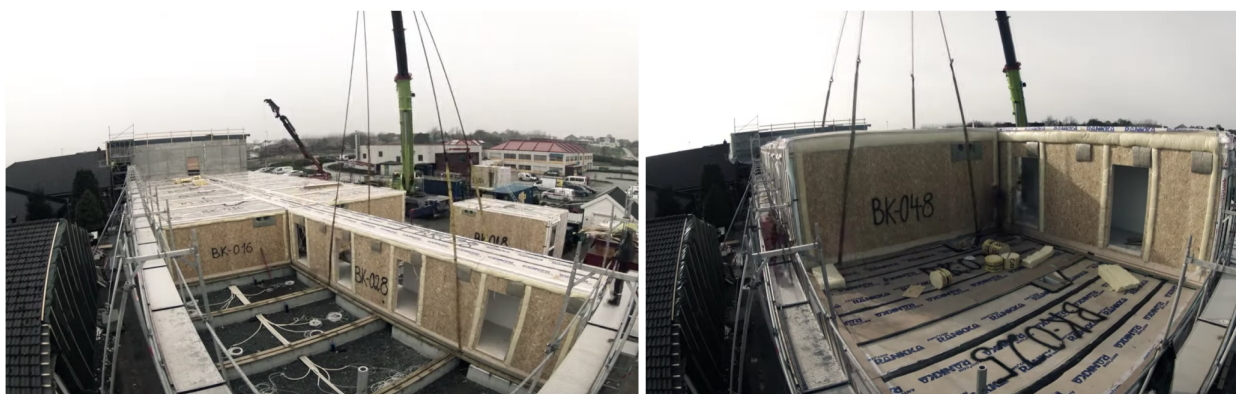
Bilde 6: Venstre: Hotellrom og gang monteres. Høyre: Andre etasje “stables” (Malthus, 2012)
