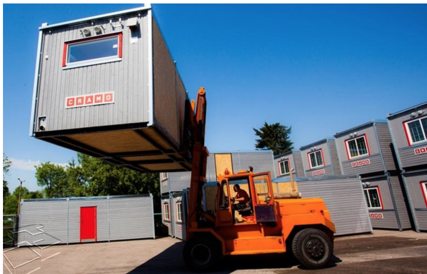
Bilde 4: Flyttbare moduler i form av en anleggsrigg (Kodumaja, 2016)
