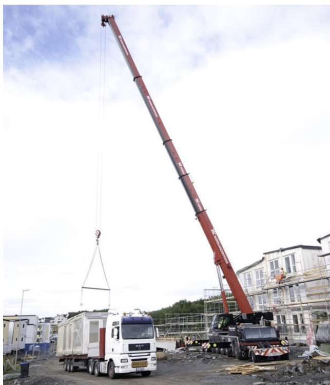
Bilde 3: Moduler heises på plass ved hjelp av kran (Kodumaja, 2016)
