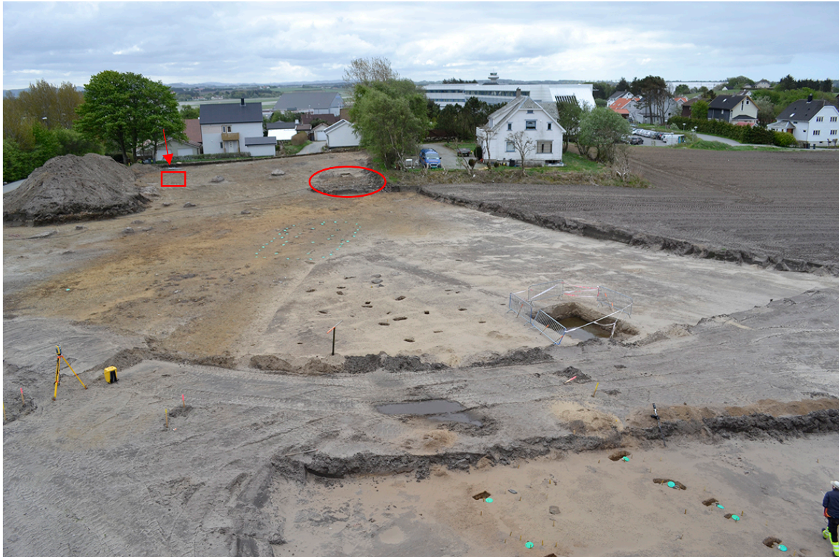
Fig. 70. Oversikt over den sørlige delen av Felt 1 med de historiske sporene markert. Pilen markerer brønn, firkanten angir kjeller, mens sirkelen viser bygningsspor. Sett mot S.
