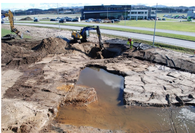
Fig. 8. Grunnvannet steg raskt etter hvert som torven og sanden ble fjernet. Her graves det hull for å sette ned en kum i den østlige ytterkanten av Lokalitet 9. Sett mot Ø/NØ
