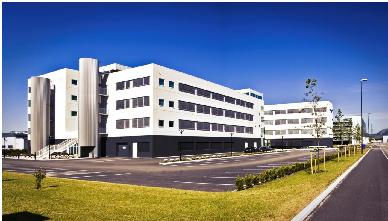
Figur 5 - Nybygg på Forus vest ligger sentralt på tomten med parkeringsplass rundt (Foto: Helge Sivertsen).
