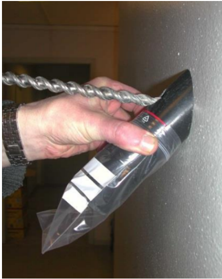
Figur 20: Betongstøv bores ut av konstruksjonen for analyse av kloridinnhold (Rapid Chloride Test). Håndbok V441 [2]
