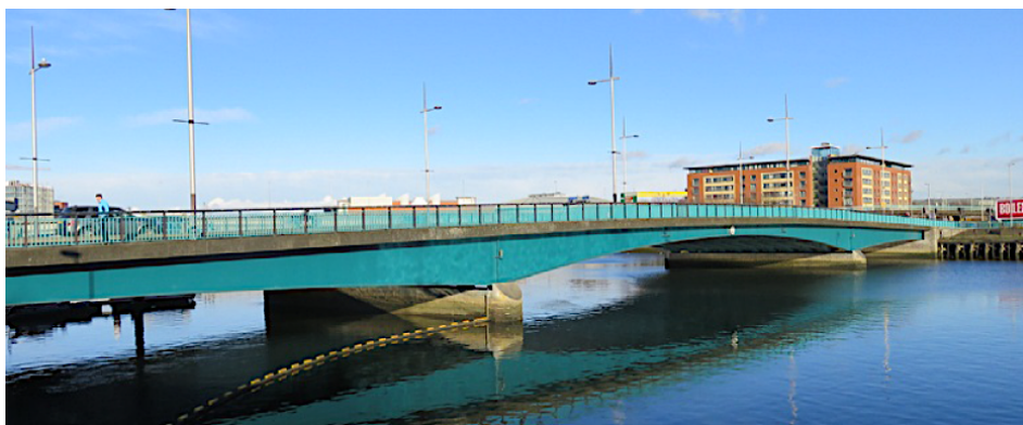
Figur 5: Queen Elizabeth II bru (stål sammenhengende bjelkebru). Belfast, Nord Irland [4]
