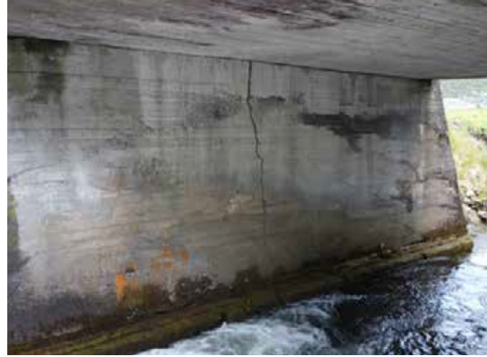
Figur 25: Grov sprekk på en landkarfront [15]
