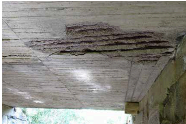
Figur 23: Armeringskorrosjon [15]
