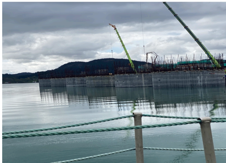
Figur 15 Betongkonstruksjonene til Hywind Tampen
