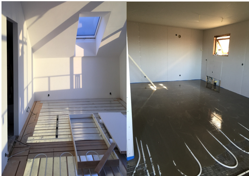
Figur 4-7 t.v. topp etg. viser Selencio plate. t.h. flytsparkling kjeller
