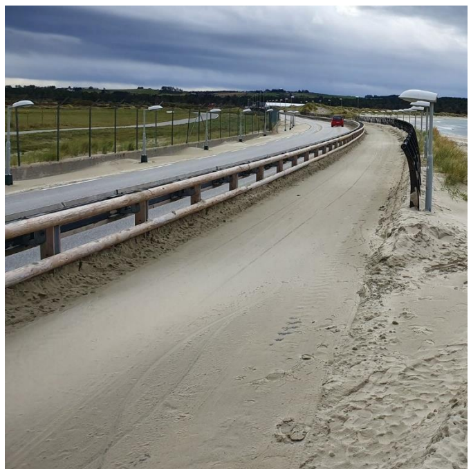
37 Visualisering av prinsipp for L2-veg ved Solastranden. Lånt fra Stavanger Aftenblad. side 50 av 70
