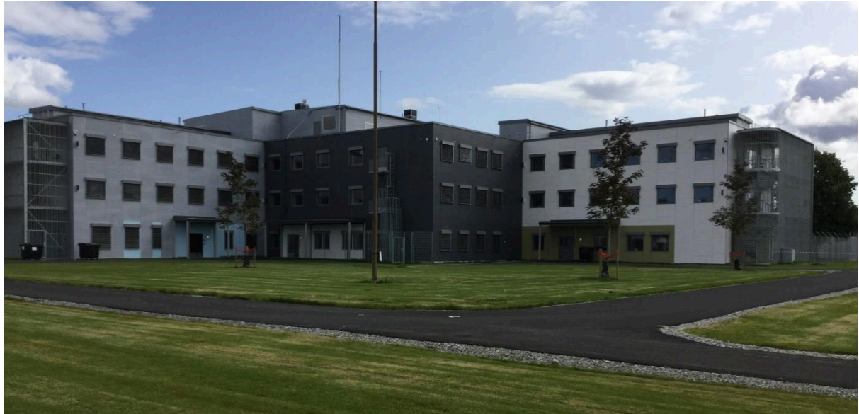
Figur 6 - Ullersmo Fengsel; Bygg M2015
