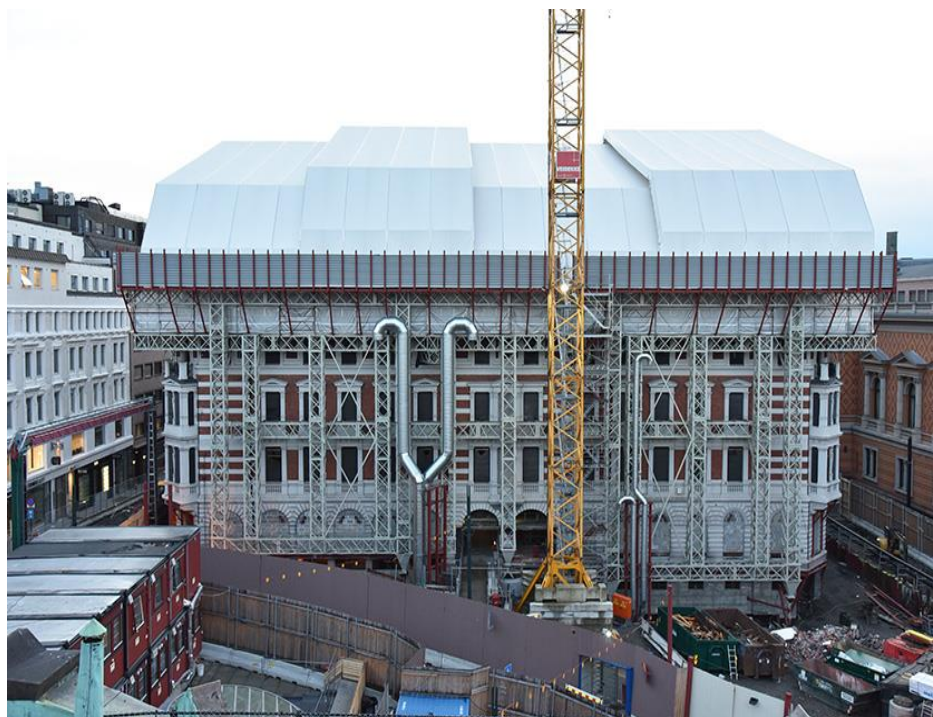
Figur 11: Oversiktsbilde av Prinsens gate 26 underveis i prosjektet (Veidekke)
