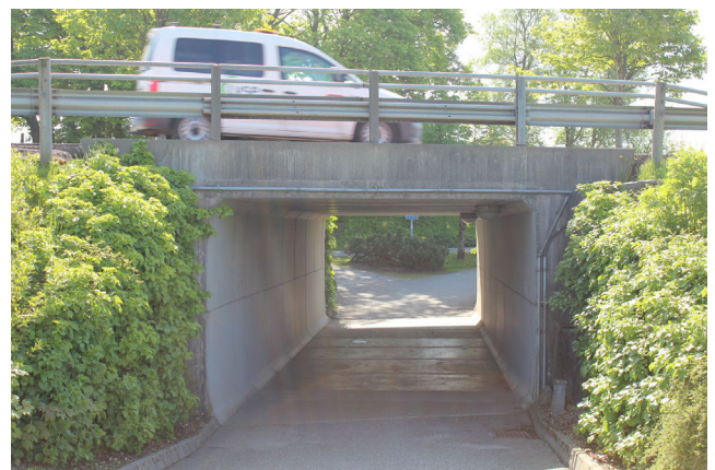
Figur 5.14: Undergang ved Jærveien (28. mai 2021).
