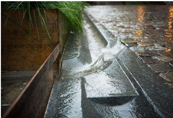
Figur 15 Vannrenne i Deichmansgate. Foto av Åse Holte (Asplan Viak, 2017)
