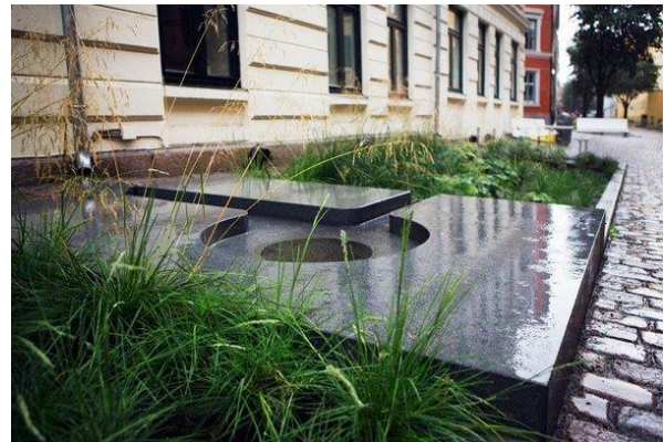
Figur 13 Vannrenne og regnbed i Deichmansgate. Foto av Åse Holte (Asplan Viak, 2017)
