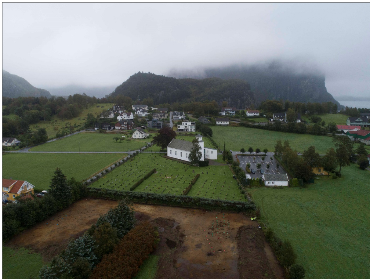
Figur 26. Oversikt over utgravingsfeltet med kirka og Uburen i bakgrunnen. Hestamoen og deretter Forsandmoen ligger like bak Ryggjen som er forhøyningen til venstre for og bak det nye boligfeltet midt i bildet. Hus 1 grønt, Hus 2 rødt, Hus 3 blått, Hus 4 gult. Dronefoto av The Gil, AM, UiS.
