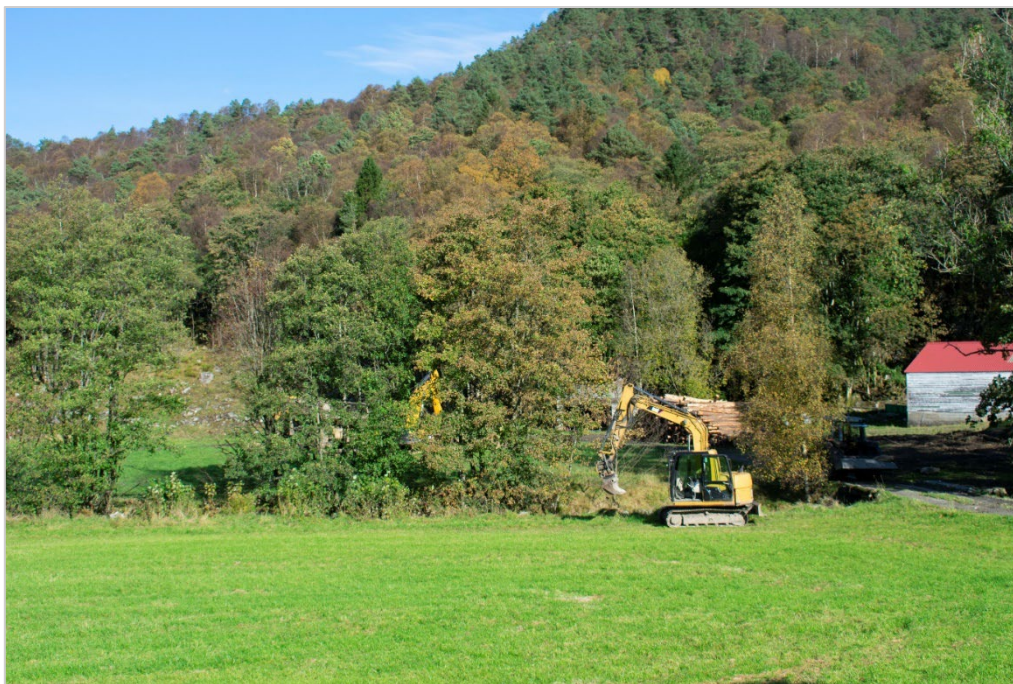
Figur 4: Lokaliteten før feltet ble avdekket. Hravemaskinen står der smien har vært. Elven ligger ved trelinjen bak gravemaskinen og broen kan skimtes til høyre i foto. Tatt mot NO. Foto: Am.
