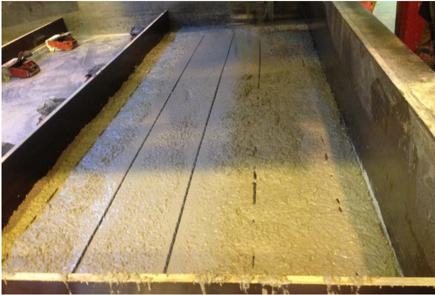
Figur 7-13: Støpeform for fullskalaelement 1007 med basaltstenger.
