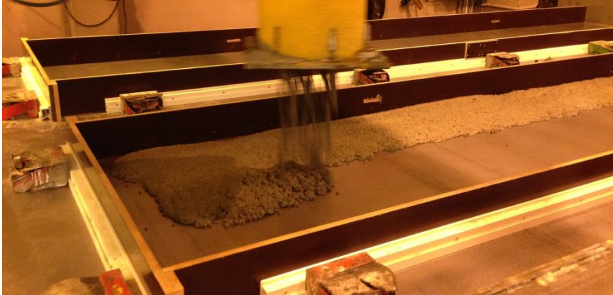
Figur 7-11: Støpeformer for fullskalaelementer med målene 6m x 1,2m.
