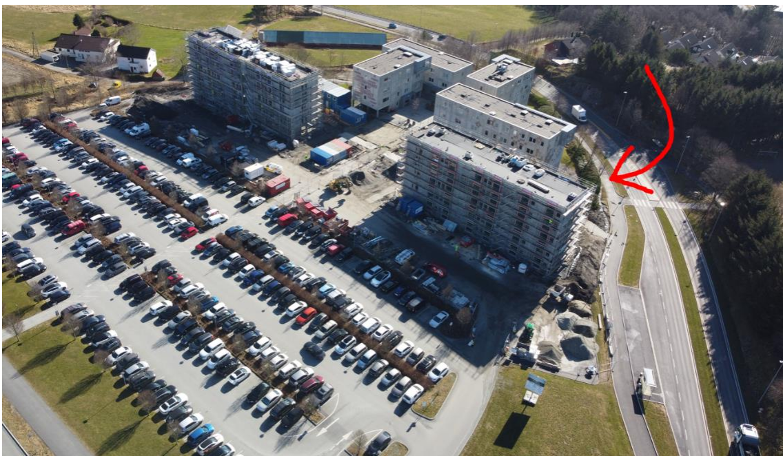
Figur 1.1.3 BS6 under byggefase
