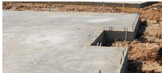
Figur 3.6.2 Støpt Fundament [28]
