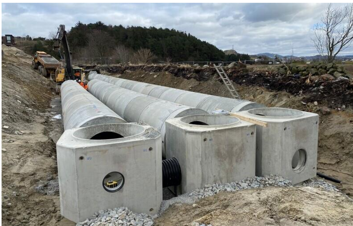
Figur 13. Lukket fordrøyningsløsning av betongrør – Skjæveland cementstøperi
