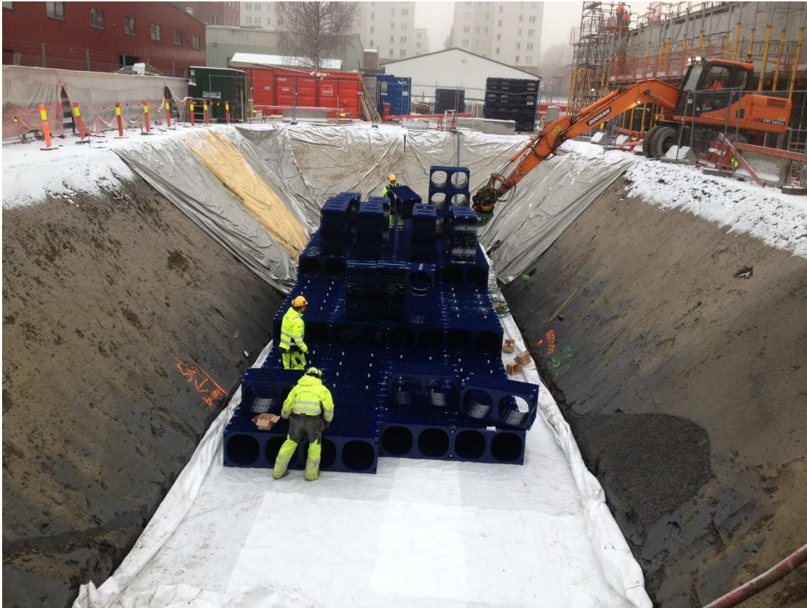
Figur 14. Lukket fordrøyningsløsning av plastkassetter - Wavin
