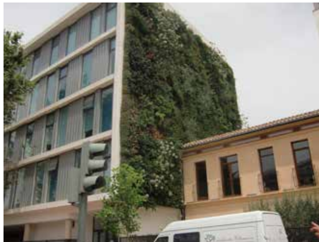
Figur 6.4: Grønn vegg på passiv fasade i Valencia som er med på å mykne opp bygningsuttrykket, samt noe å se på (Å.Madsen)
