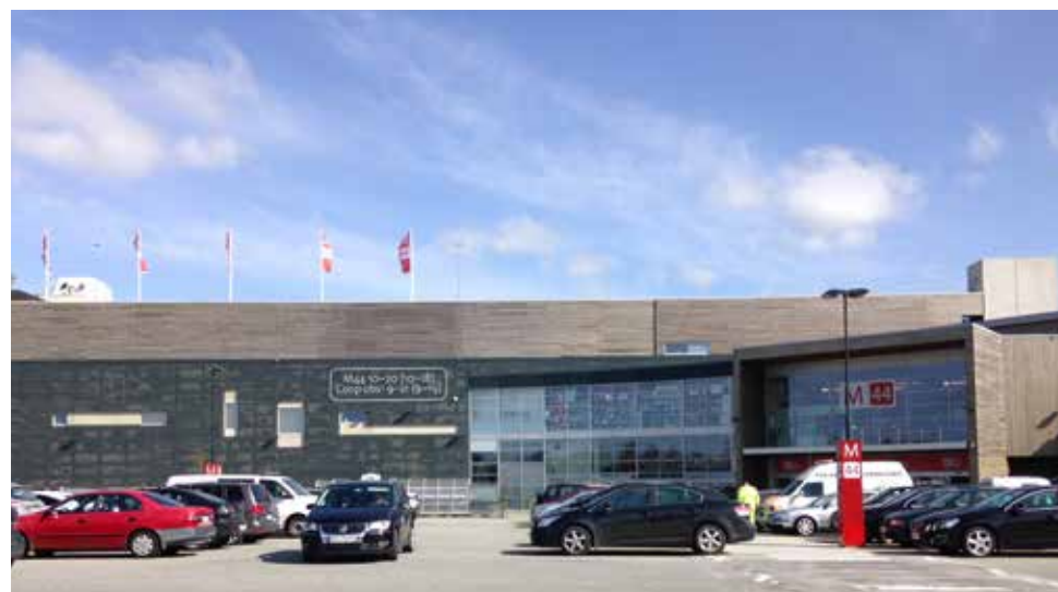
Figur 4.60: Fasaden mot vest virker dominerende og overflateparkering tar opp mye plass (Å. Madsen)
