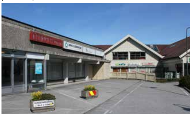
Figur 5.11: Dårlig vedlikehold av bygninger i sentrum (Å.Madsen)
