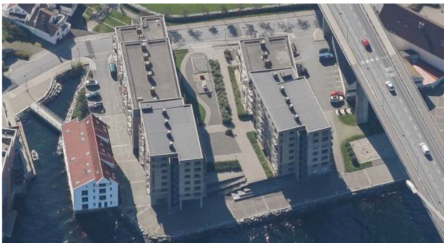
Figur 4.22 - Fellesarealet mellom Verven 36 og 38 (BlomURBEX, 2014).
