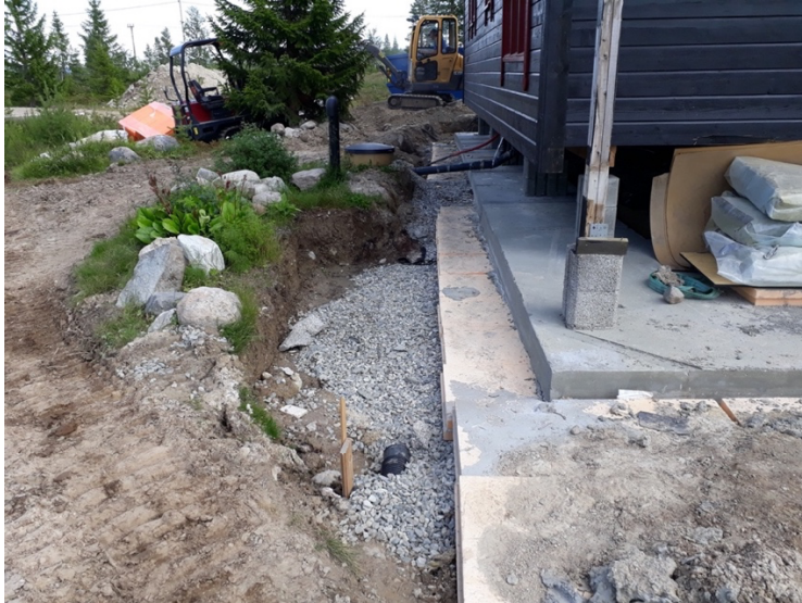
Figur 14: Bygg plassert på permanent bæring 2
