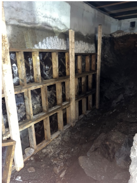
Figur 34: Forskalingskassetter 2
