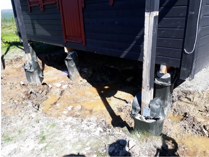
Figur 10: Konstruksjon før byggeprosessen
