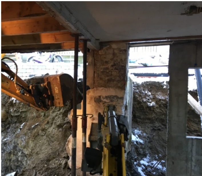
Figur 32: Riving av gammel grunnmur
