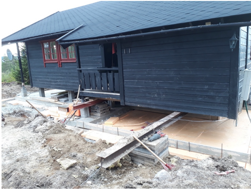
Figur 12: Bygget er heiset tilbake og plassert på midlertidig bæring
