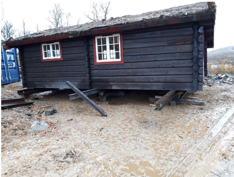
Figur 11: Bygget er flyttet og plassert på ståldragere som midlertidig bæring
