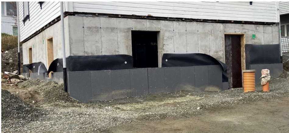
Figur 39: Isolering og tetting av kjeller
