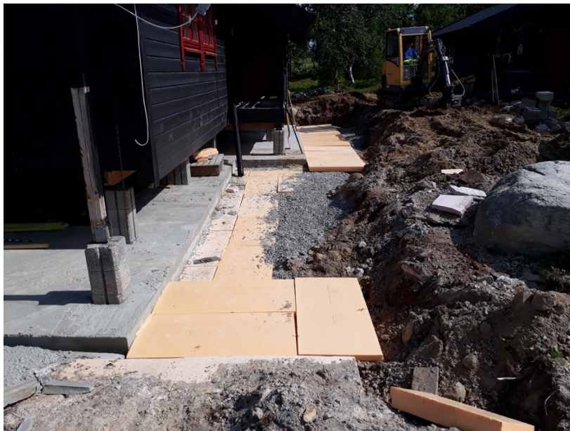
Figur 13: Bygg plassert på permanent bæring 1
