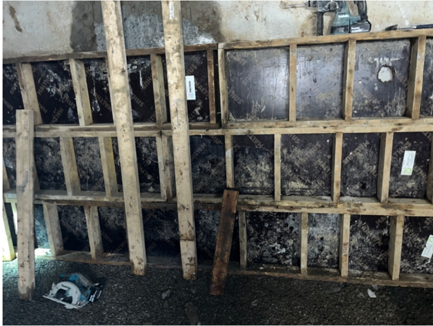
Figur 33: Forskalingskassetter 1
