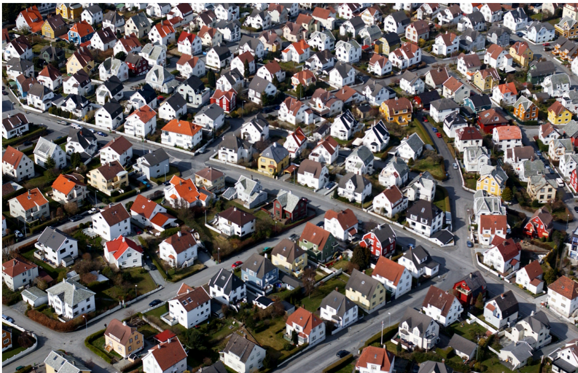
Figure 2: Picture of Stavanger Trehusbyen (Stavanger kommune, 2017)
