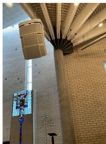
Figur 12 Innvendig bærende hetonnsøyle
