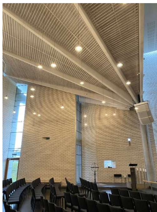
Figur 11 Del av takets bærekonstruksjon
