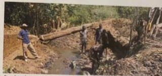
Bøndene lager en demning slik at de nye plantene skal få vann.
