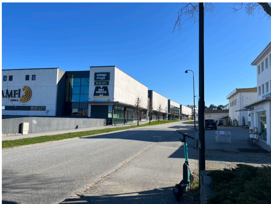
Figur 4.25: Vestlig område av bydelssentrumet hvor bebyggelsen sør for Madlakrossen skyggelegger fortauet til høyre i bildet ved morgensol. Fortauet på venstre side av veien har gode solforhold. Dette gjelder for hele gaten.
