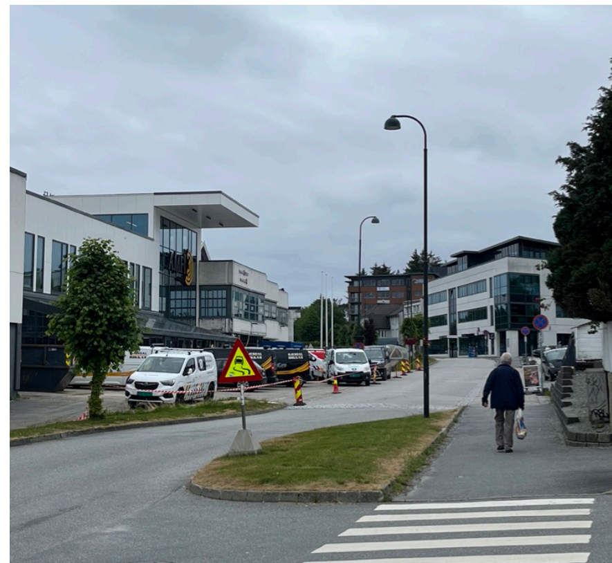
Figur 2.1: viser byggearbeider ved den ene inngangen til Amfi Madla.
