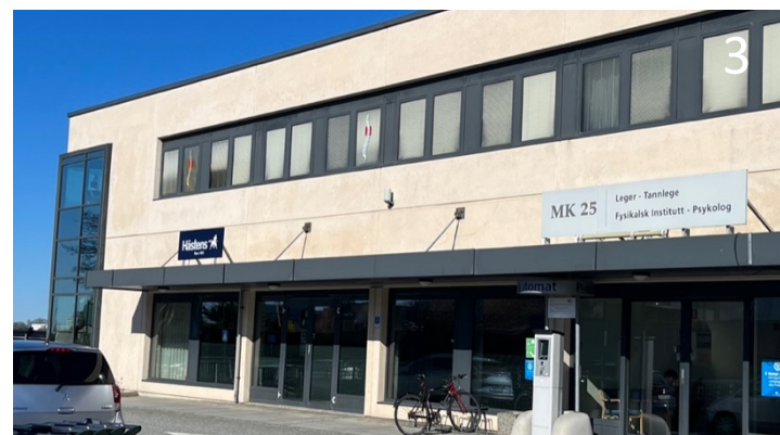
Figur 4.31: Tre bilder som viser fasadeterskler i Madla bydelsentrum.
