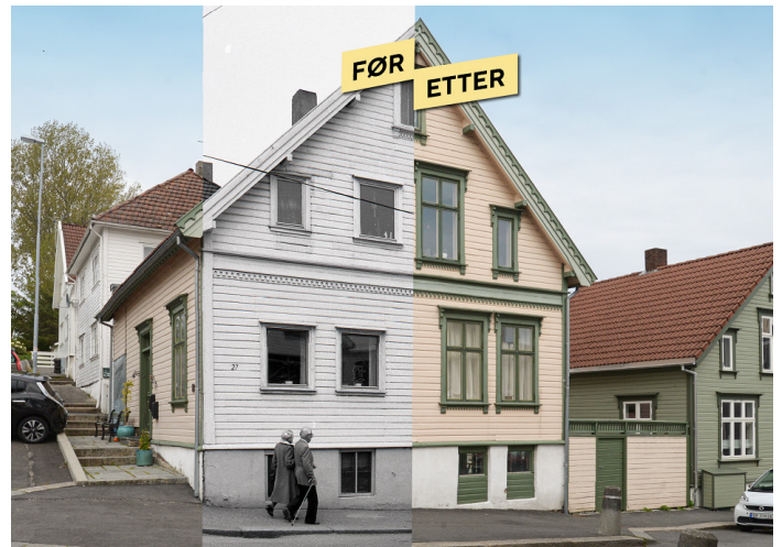
Figure 9: Before/After renovation of building in trehusbyen. ( https://www.stavanger.kommune.no/bolig-og-bygg/byantikvaren/bygging-i-trehusbyen/ )
