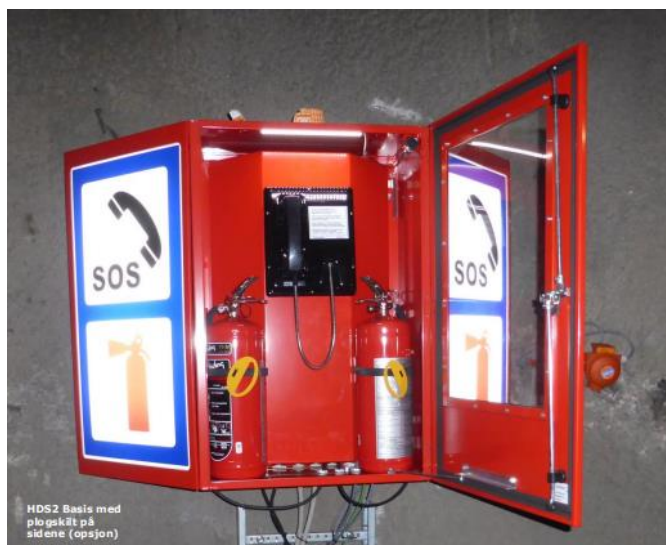
Figur 18 Illustrasjon av nødstasjon med nødtelefon (Catena, 2017, s. 8)
