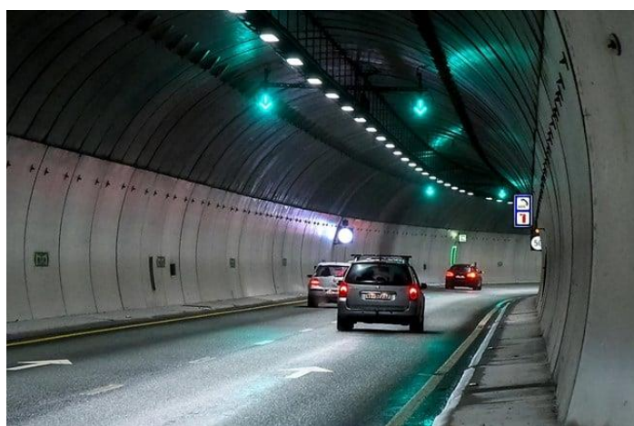
Figur 11 Illustrasjon av kjørefeltsignal (SVV, 2017)
