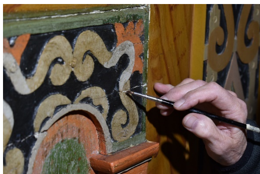
Figur 23) Punktconsolidering av løse fargelag.
