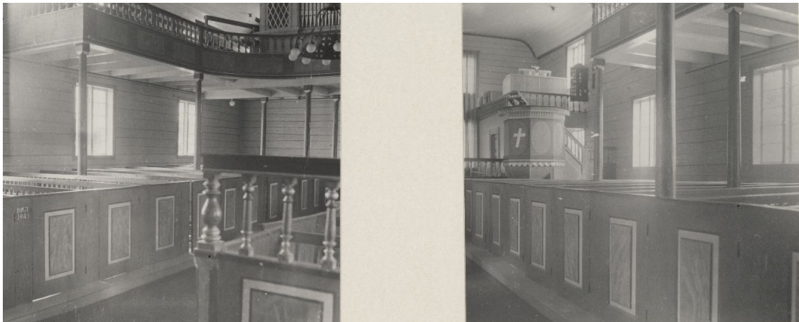
Fig. 10. 2 foto fra periode 4, fase 1. Marmorering i benkedørenes fyllinger og i malte felt på gallerifronten sees. (RA's arkiv. Ukjent fotograf.)
