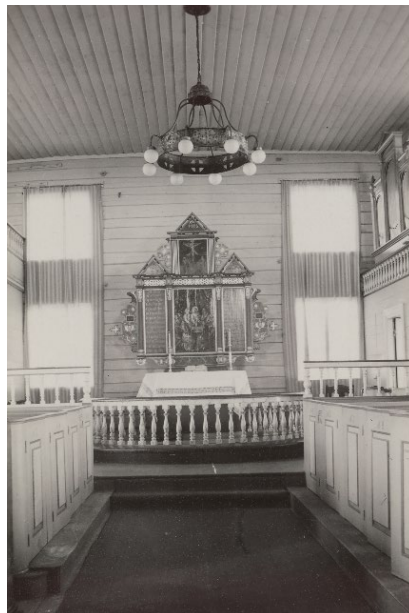
Fig. 9. Foto fra periode 3, etter avdekking av altertavlen men før oppmaling av benkedører. (RA's arkiv Foto: R. Kloster.)
