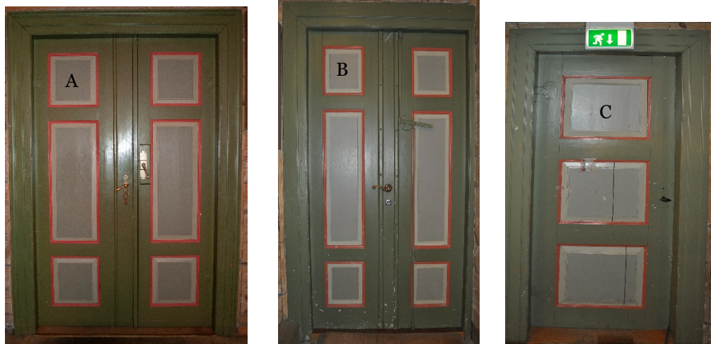
Fig. 24 A-C. 3 ulike dørbblad i kirkerommet. A: dør vestvegg skip, B: dør nordvegg skip, C: dør vestvegg galleri.
